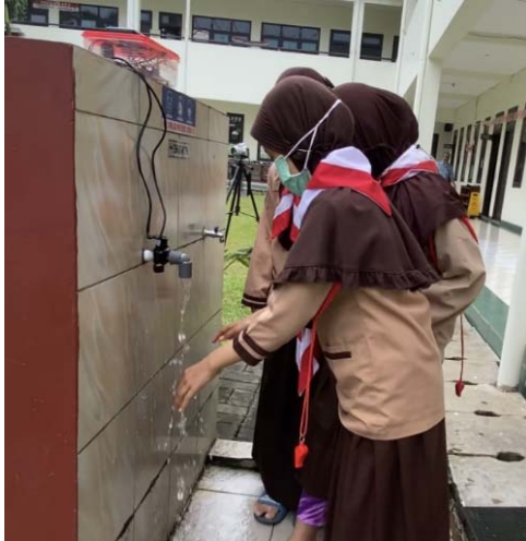
Pemasangan sistem keran wudhu tanpa sentuh di SD Citra Islami
