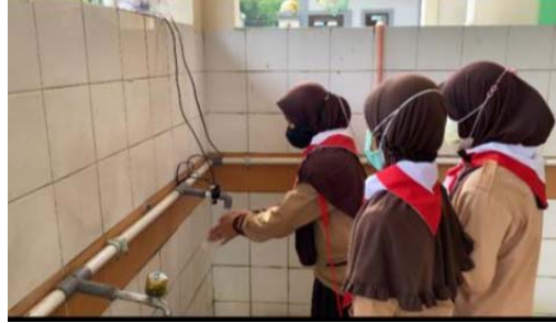
Pemasangan sistem keran wudhu tanpa sentuh di Masjid Al Ikhwan, Citra Raya
